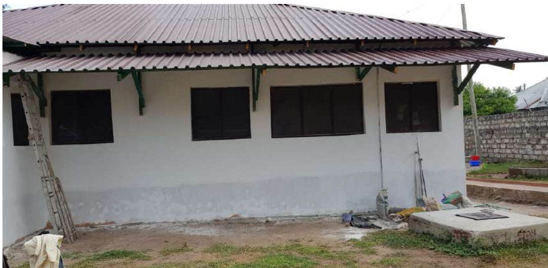
In 2019 zijn ook de renovatiewerkzaamheden afgemaakt.
